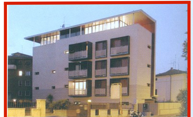
30 Edificio residenziale Via Cagliari 31, Verona Alberto Burro e Alessandra Bertoldi, 2003-2005 [foto ABW]
